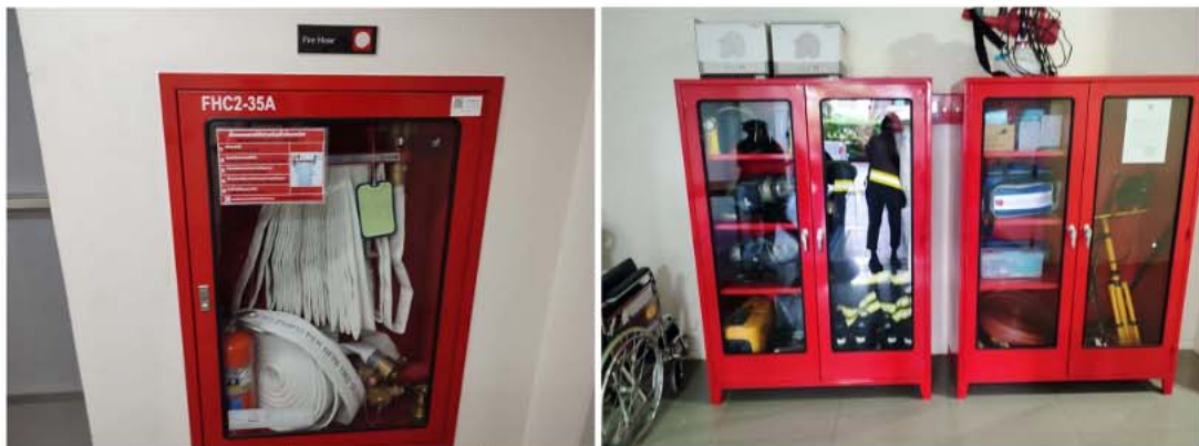
ภาพที่ 3-19 ตู้เก็บสายฉีดน้ำดับเพลิงและอุปกรณ์ มีสภาพสมบูรณ์พร้อมใช้งาน
