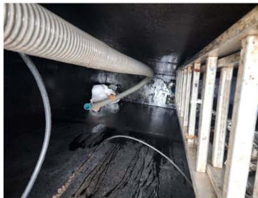
ภาพที่ 3-37 สูดตะกอนในระบบบำบัดน้ำเสีย
