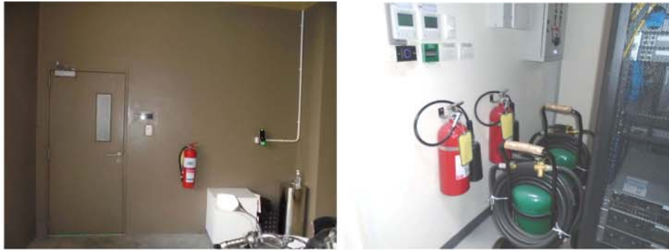
ภาพที่ 3-26 ถังเคมีดับเพลิงและป้ายคำแนะนำติดไว้
