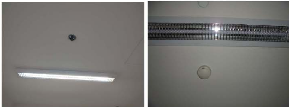
ภาพที่ 3-20 หัวกระจายน้ำอัตโนมัติและเครื่องตรวจจับควัน มีสภาพสมบูรณ์พร้อมใช้งานและใช้หลอดไฟ LED
