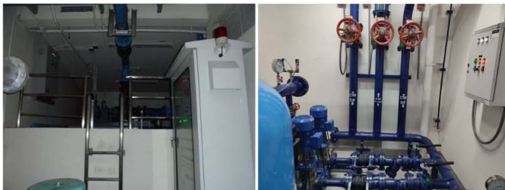
ภาพที่ 3-10 ห้องเครื่องประปา และถังสำรองน้ำใช้ ระบบท่อต่างๆ ไม่มีรั่วซึม
